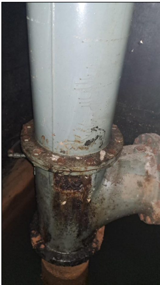
Abbildung 11: Abgang Rohrschachtpumpe, daneben Absperrschieber druckseitig mit Ausbaustück und Wanddurchführung
