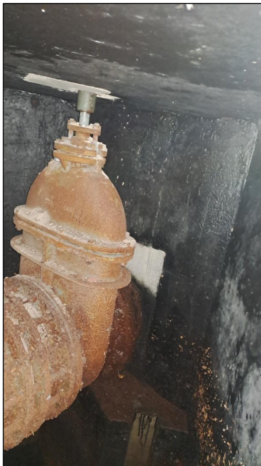
Abbildung 11: Abgang Rohrschachtpumpe, daneben Absperrschieber druckseitig mit Ausbaustück und Wanddurchführung
