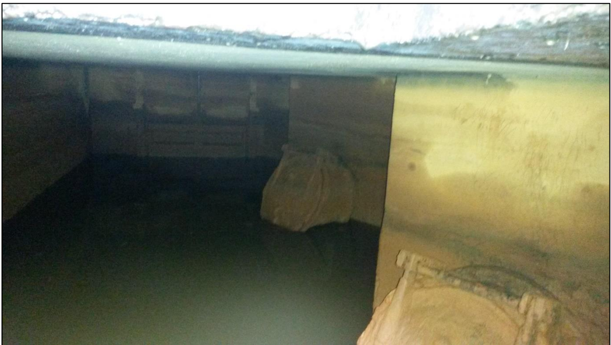
Abbildung 13: Auslaufkammer mit Rückschlagklappen und dahinter befindlichem Gewindeschieber
