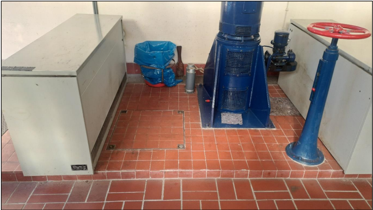
Abbildung 8: Pumpe 2 mit Schachtabdeckung und Antriebssäule Absperrschieber
