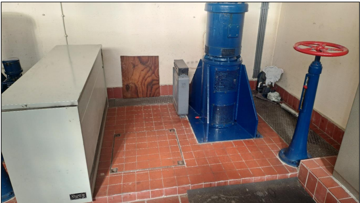
Abbildung 9: Pumpe 3 mit Schachtabdeckung und Antriebssäule Absperrschieber
