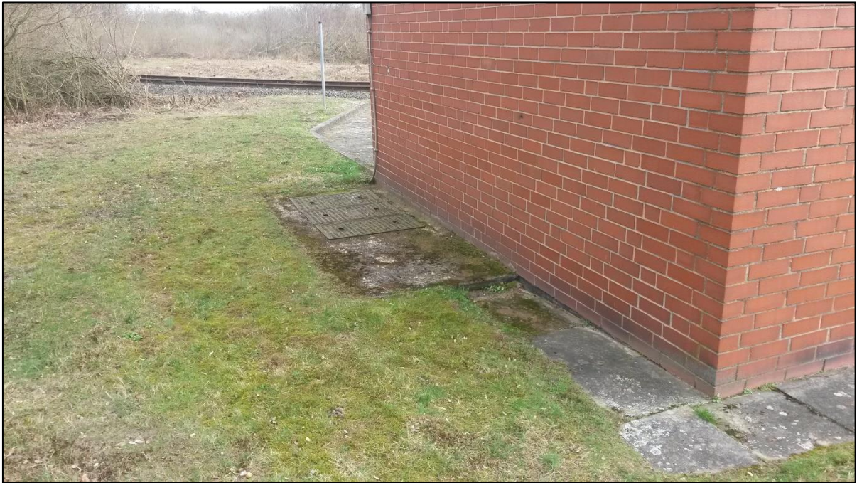
Abbildung 12: Reihenabdeckung Ablaufkammer
